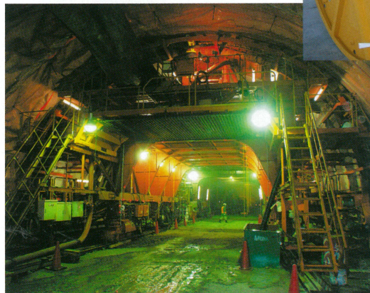
トンネル養生シート
